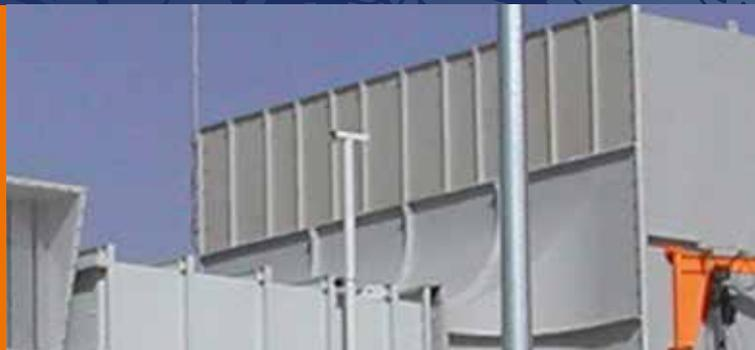
Das Schallschutzelement mit schallabsorbierender, gelochter Innenschale ist vorwiegend für Innendeck-schalen geeignet. In dem von Metecno patentierten System ist zwischen der Innenschale und dem Dämmkern aus Mineralwolle ein spezielles Vlies als Rieselschutz eingelegt. Die Ausbildung der Innenschale trägt erheblich zur Verbesserung der Raumakustik bei. Außerdem werden durch die hohe Dichte des Dämmkerns gute Schalldämm-werte erreicht.
